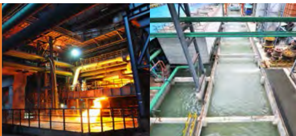
图3.4 - 电炉炉渣通过淡水冷却（左）。使用过的水流往冷却塔。（右）
